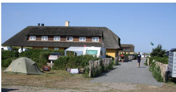
Figur 6 Servicebygning beliggende indenfor planområdet
